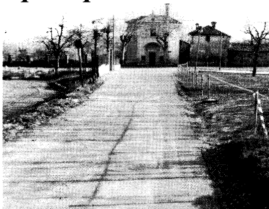
Asfaltata la strada di San Quintino
