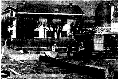
Lavori al Centro Diurno
