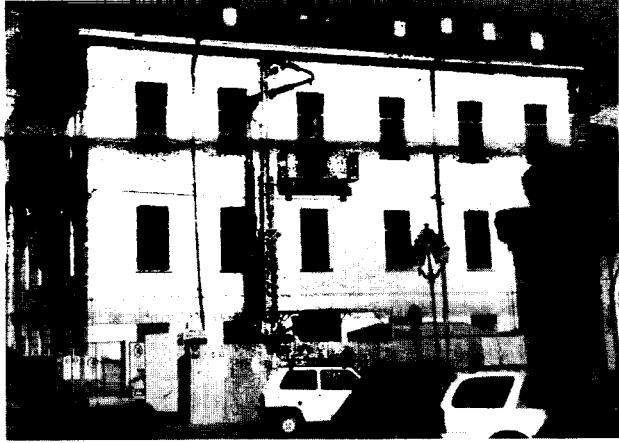
Lavori alla nuova sede del Civico Istituto Musicale
