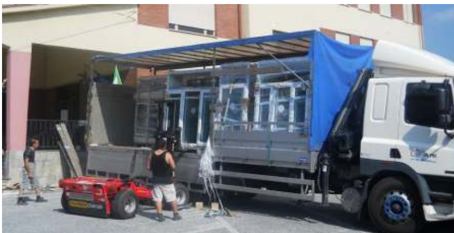
Investimenti straordinari negli edifici scolastici: qui i nuovi infissi per le scuole medie
