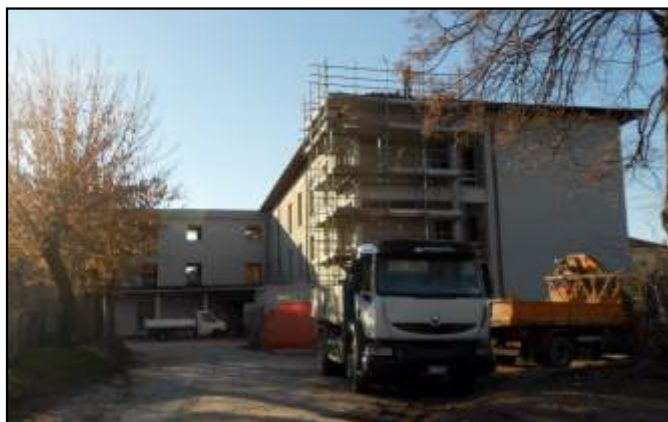
Cantiere ampliamento casa di riposo
