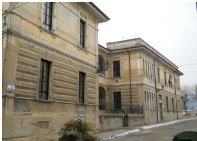
Biblioteca e scuole primarie ala vecchia prima e dopo il restauro
