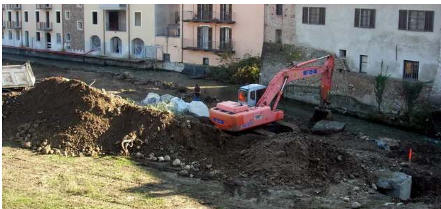
Nuova viabilità: il cantiere sul Talutto per il parcheggio in piazza Giovanni Paolo II
