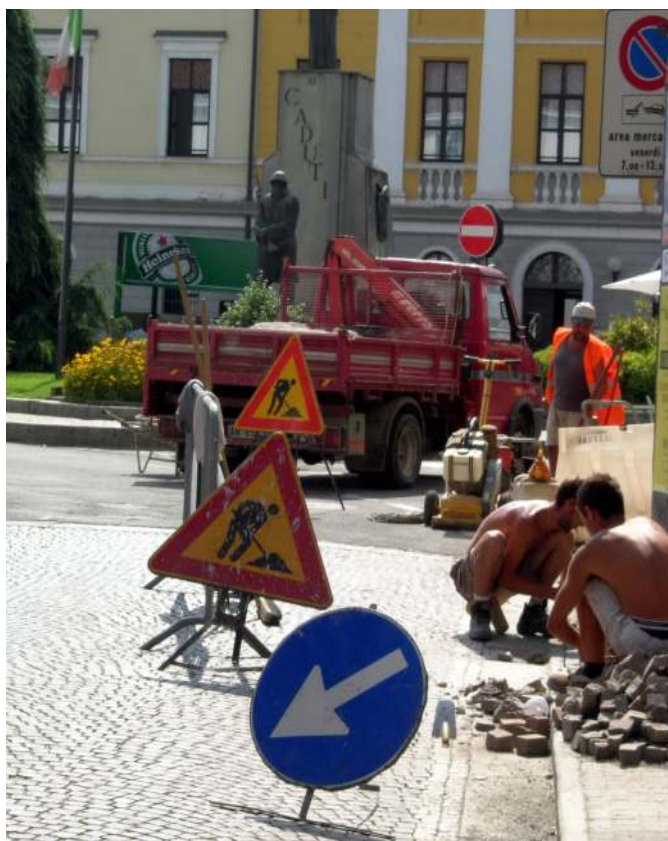
Cantiere per zona 30km/h e abbattimento barriere architettoniche
