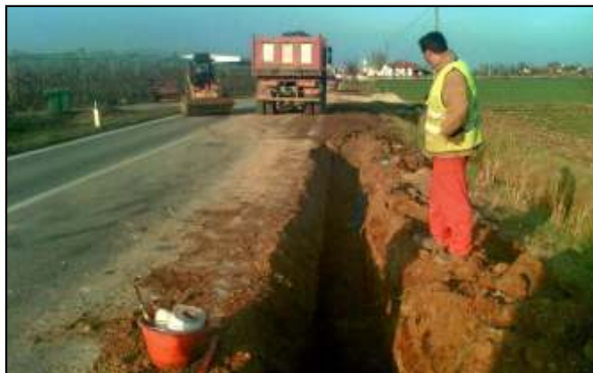
Cantiere per la posa del nuovo acquedotto
