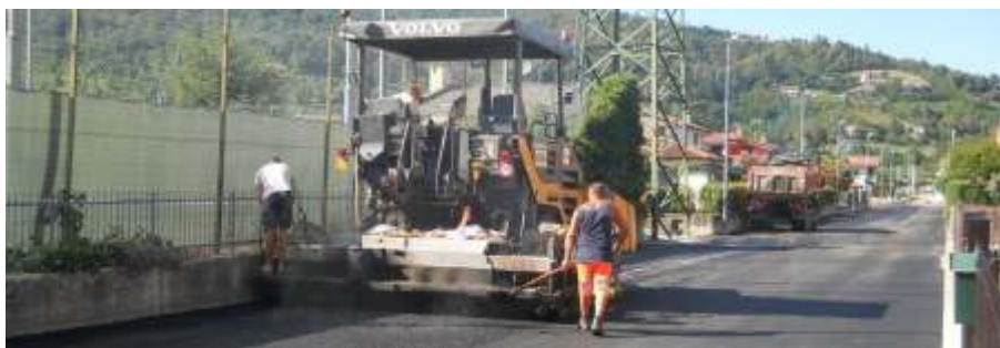
Nuova viabilità: il cantiere in via Pes di Villamarina
