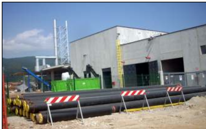
Tubature pronte per essere interrare per il teleriscaldamento
